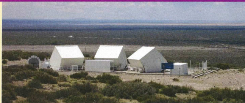
Kamery HEAT (Coihueco; 1 750 m n. m.) osazené českými zrcadly pro pozorování spršek s nižšími energiemi částic i přilehlá část pampy s hustěji osazenými pozemními i podzemními detektory a anténami.
