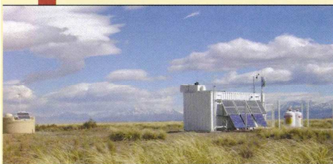
Přibližně uprostřed observatoře funguje centrální lidar pro měření průzračnosti atmosféry během nočních pozorování. Vlevo je vidět instalovaný pozemní dektor, v jehož nádrži je 12 t destilované vody.
